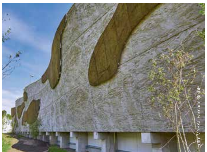
Lärmschutzwand der Krombacher Brauerei in Form von Moos-Inseln auf einer Fläche von 270 Quadratmetern.
